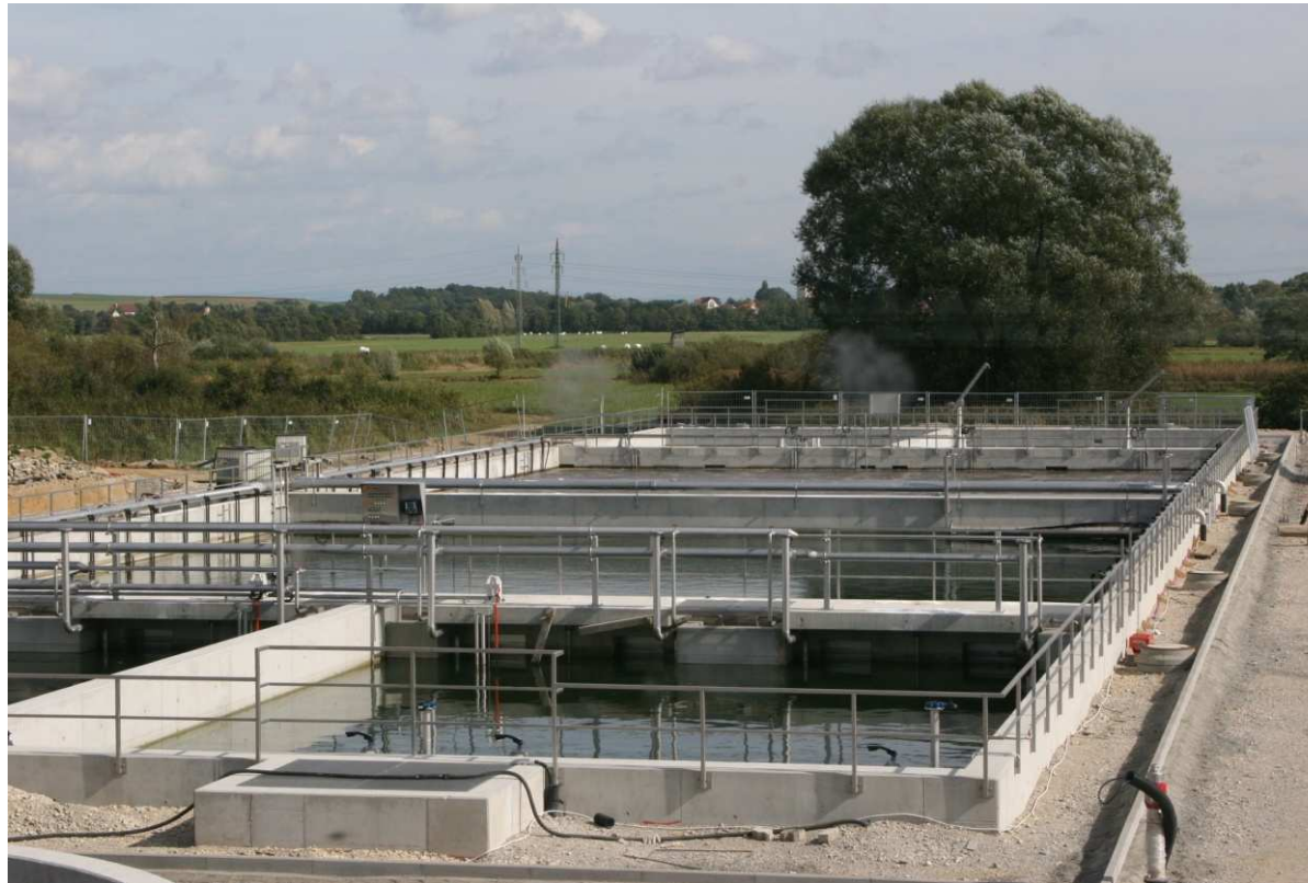
Municipality of Schierling, Germany, 20.000 PE
