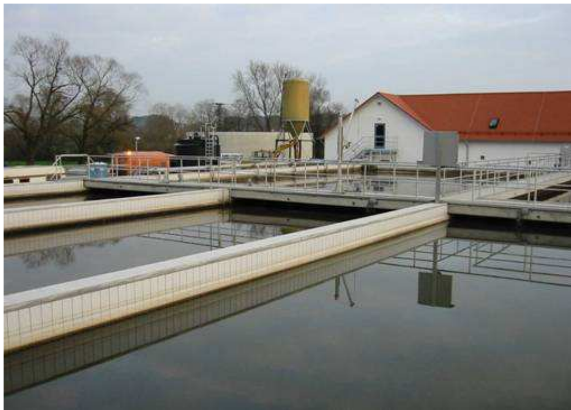
Municipality of Petershausen, Germany, 10.000 PE
