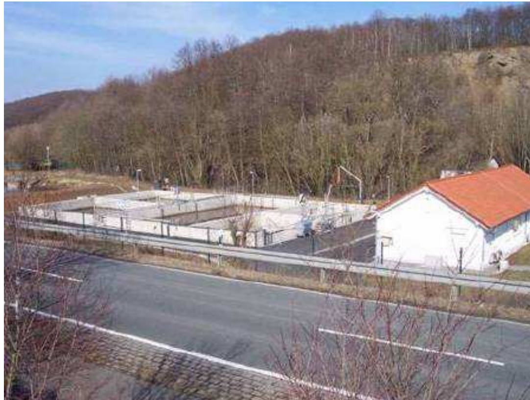
Municipality of Niederwetz, Germany, 3.000 PE
